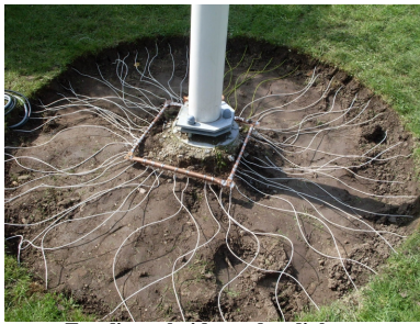
Færdigt arbejde med radialer
