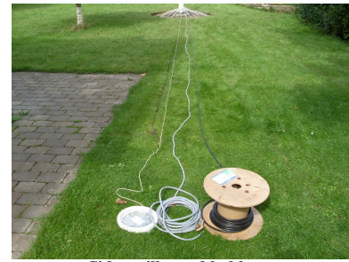
Sidste rille med kabler
